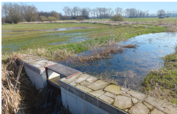
Jedno z deseti hradítek, kterými řídíme množství vody v jednotlivých částech ptačího parku.
