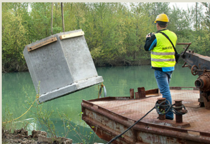
Instalace ostrůvků se neobejde bez těžké techniky.
