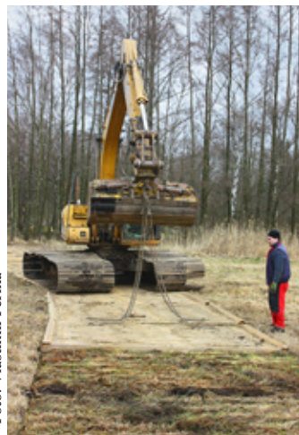
Odklizení mobilní vozovky z kovových panelů.
