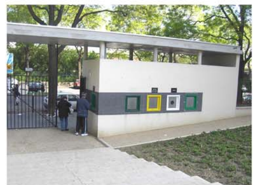
Nouvel accès sécurisé tours H et I, tri sélectif
