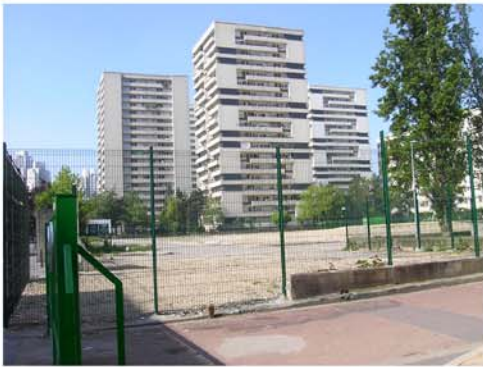
Tours M, P, O, après démolition des bâtiments municipaux
