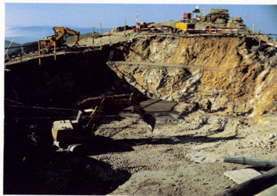
▲ Ouverture du chantier, excavation, septembre 1975
