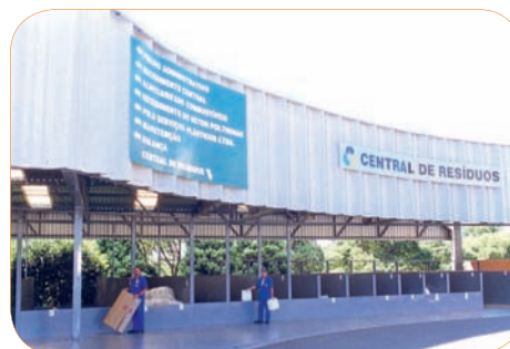
1999 - Central de Resíduos
