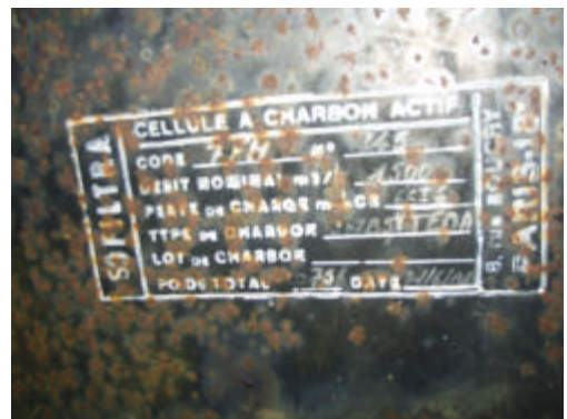
Restes des caissons à charbon actif datés de juin 1968 et destinés à épurer l'air des iodes radioactifs avant insufflation dans le hangar destiné à la protection des populations lors des retombées radioactives à Rikitea sur l'île de Mangareva (Gambier). Photos : D. Palacz, 2005
