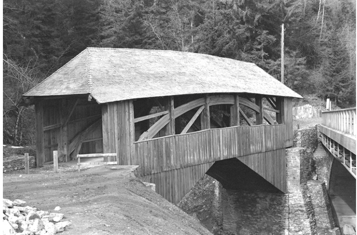
Die Eggatobelbrücke zwischen Malix und Churwalden. Die 1836 erbaute Brücke wurde 1989/90 restauriert. Abb. 1 (Hj, 25. 3. 1994)
