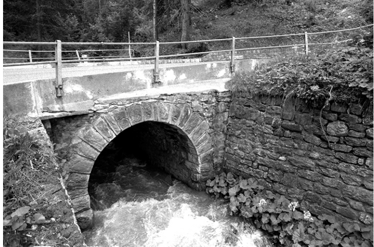
Kleine gemörtelte Brücke unterhalb von Parpan mit neuzeitlichem Betonaufsatz. Abb. 4 (Heg, 1. 7. 1987)
