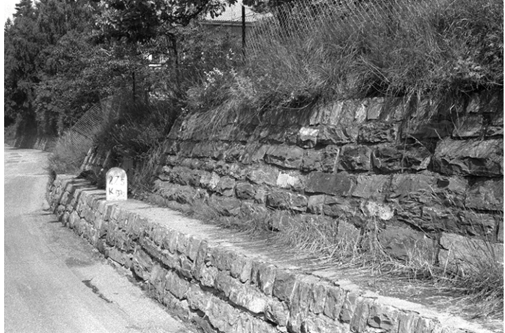
Berme mit Grenzstein wenig oberhalb Tiefencastel. Abb. 6 (Heg, 2. 7. 1987)
