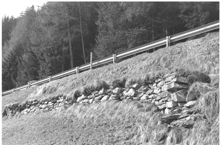
Stützmauerrelikte eines früheren Verlaufs vor Churwalden. Das Strassentrassée wurde möglicherweise bei den Korrekturen zwischen 1935 und 1940 nach oben verlegt. Abb. 2 (Hj, 25. 3. 1994)
