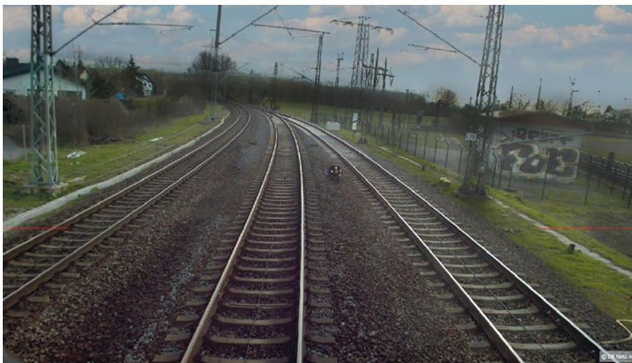
Abb. 4: Der Bogen Biblis erlaubt im Bestand nur 90 km/h, die Geschwindigkeit konnte aber im Zuge der Generalsanierung bestandsnah angehoben werden.
