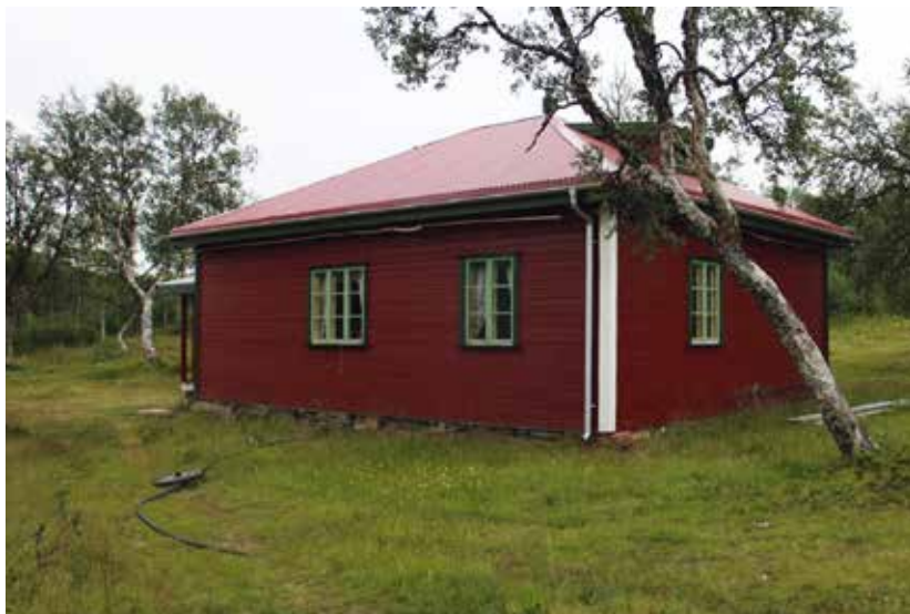
Huset som Lars Larsson Kråik lät bygga på 1930-talet är i dag moderniserat men ser i princip ut som det gjorde när det var nybyggt.
