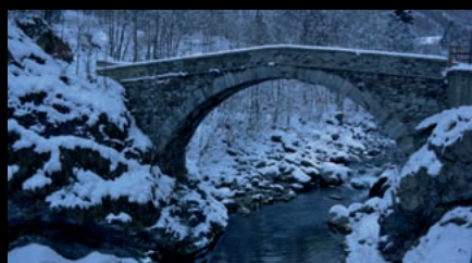
Fobello, ponte in località Oltracque
