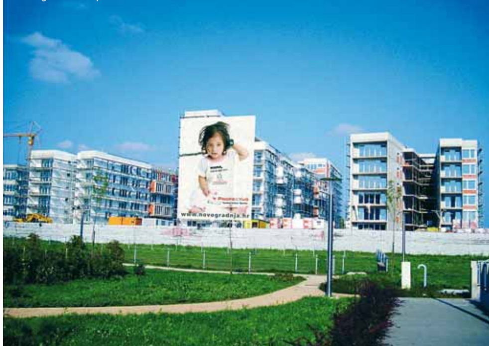
Veliko gradilište u Španskom
