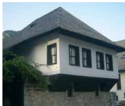
Rodna kuća Ive Andrića, rekonstruirana u obliku starih bosanskih kuća danas je muzej
