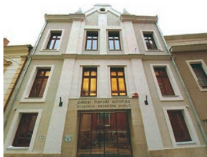
Nova, obnovljena zgrada Hrvatskog kazališta u Pečuhu
