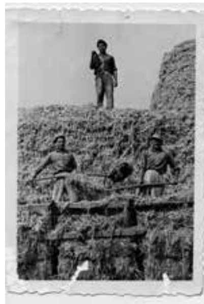
Descargando gramisa. Este material se utilizaba como combustible para quemar el yeso. La Tejera y yesera.
