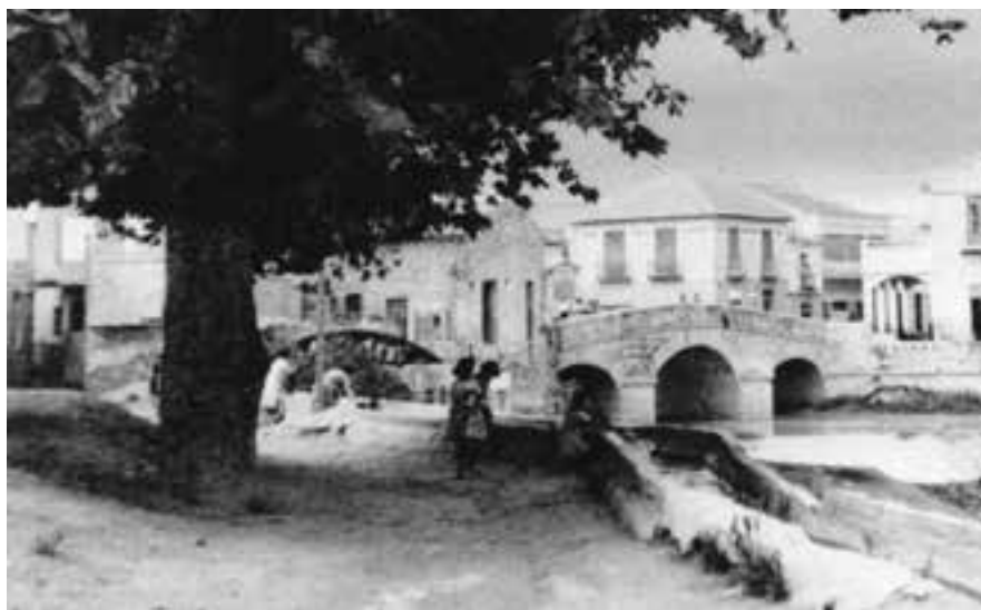
En primer término la Hila de la Noria. Acueducto que canaliza el primer tramo de la Acequia de la Noria de La Bernada.
