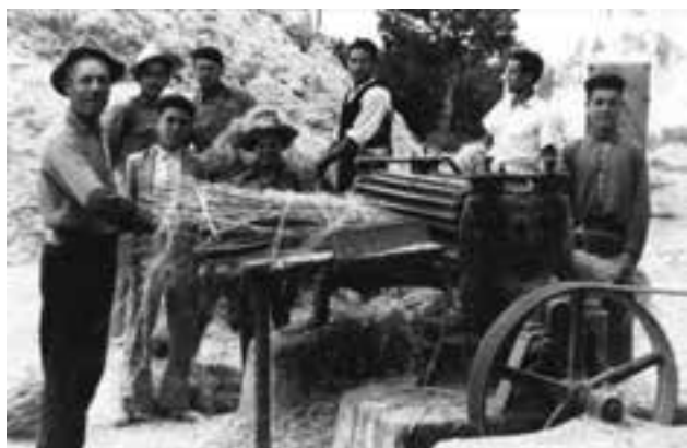
Obrador especializado en la transformación del cáñamo (Rojales). Agramadores trabajando con la agramadora mecánica.
