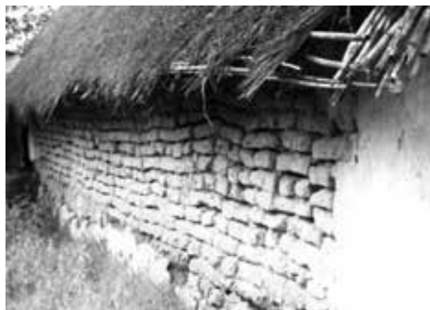
En primer plano se ven las atobas, que era normalmente el material utilizado para la construcción de los muros de las barracas.
