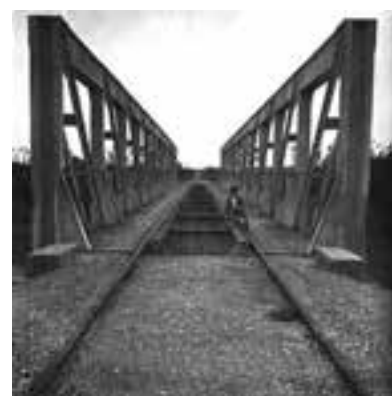
Puente de hierro sobre el río Segura (FF CC. Albatera-Torreveija). Año 1889.
