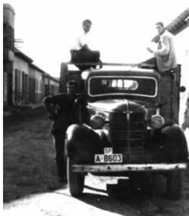
Camión de transporte en una calle de la localidad.
