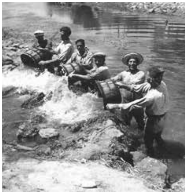
Sacando agua a "portaera". Principalmente, se utilizaba este sistema cuando el agua que venía por la acequia no llegaba con suficiente altura para regar.
