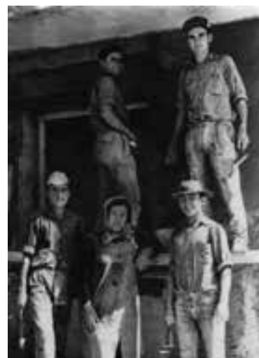
Albañiles revocando paredes en Heredades.
