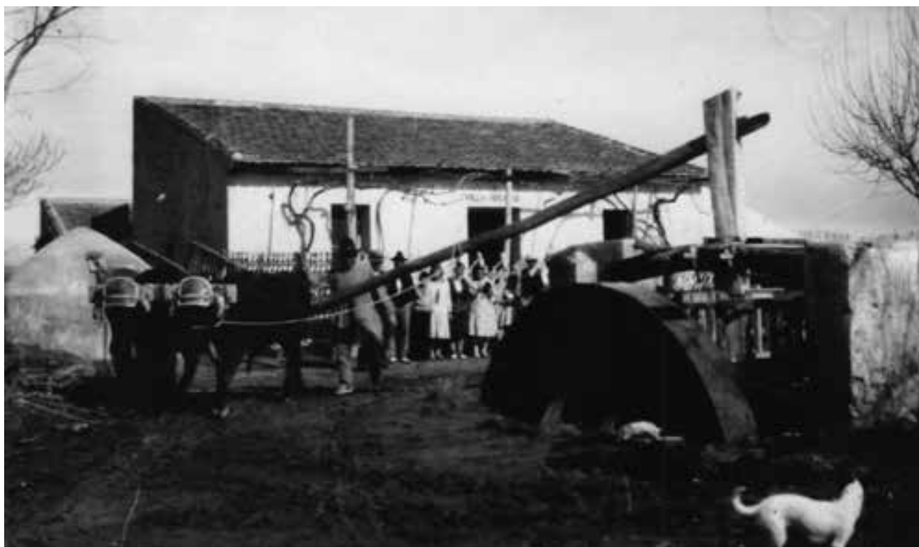
Cenia de sangre o de tracción animal. Estas ruedas elevadoras de agua proliferan en la Vega Baja hasta su total desaparición entre los años 60 y 70 del siglo XX.
