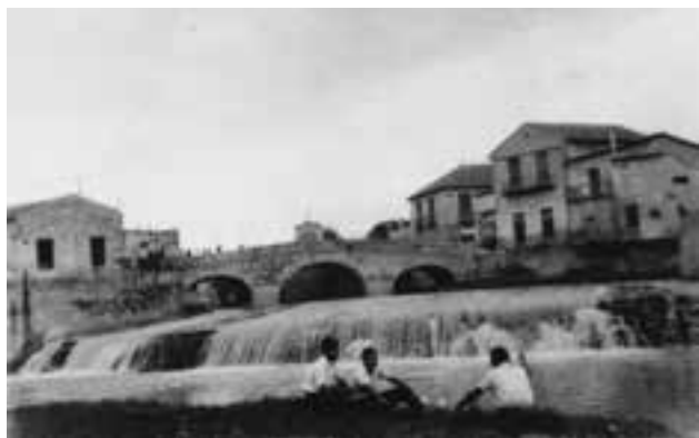
El azud de Rojas. Presa de grandes sillares que desvía la corriente del río por el canal de captura de las acequias mayores y la noria, fue construido en el siglo XVI.
