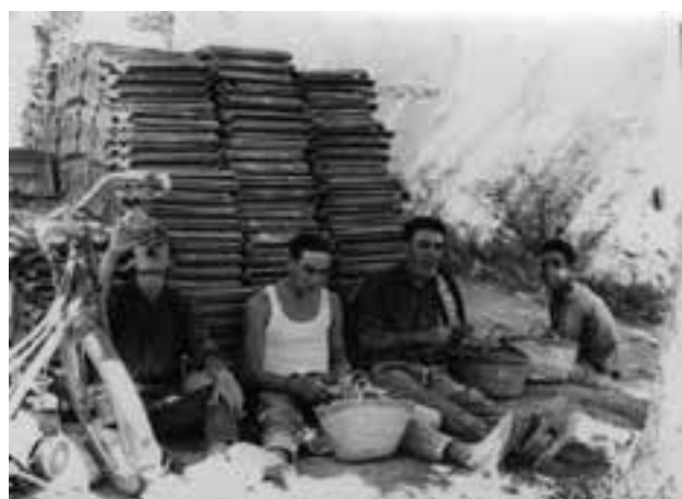
Albañiles almorzando en el “tajo”.
