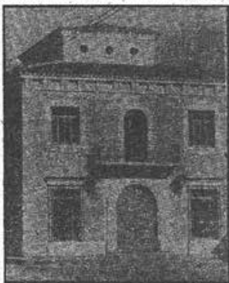
Nuevo edificio del Ayuntamiento de Rojas
