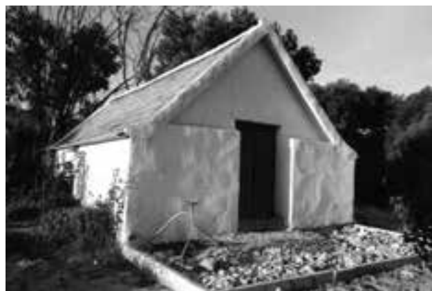
Casa abarracada de Lo Pepín (Rojales) restaurada.
