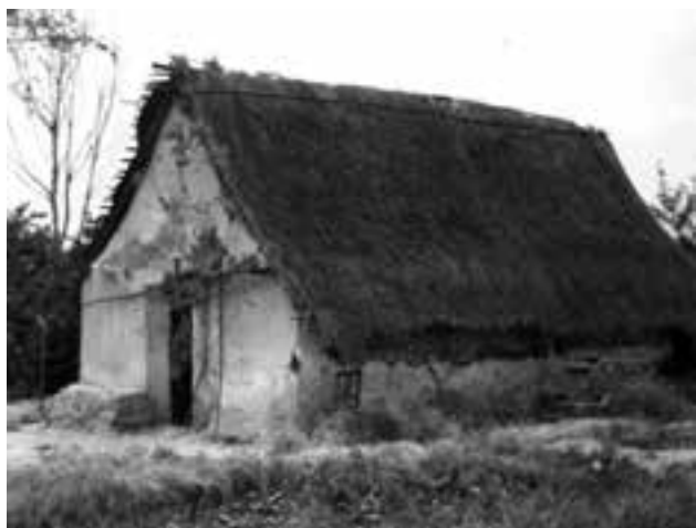
Barraca. Los materiales utilizados en la construcción eran las atobas para las paredes y la sisca y cañas de olivo para el techo.
