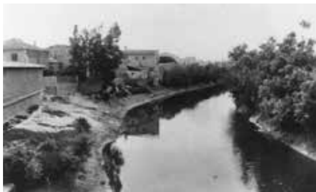
Río Segura a su paso por la población (año 1931). A la izquierda grupo de casas antes de la construcción de los muros de contención y los malecones del río.
