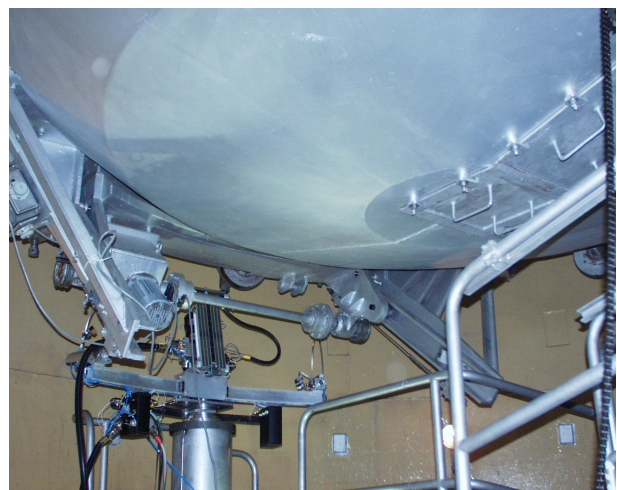
1. ábra: A reaktortartály elliptikus fenék termikus/biológiai védelme, Paks NPP
