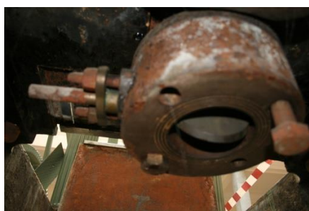
Figura 73: Válvula de mariposa
