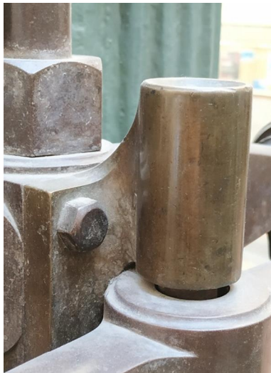
Figura 177: Conexión entre barras distribución
