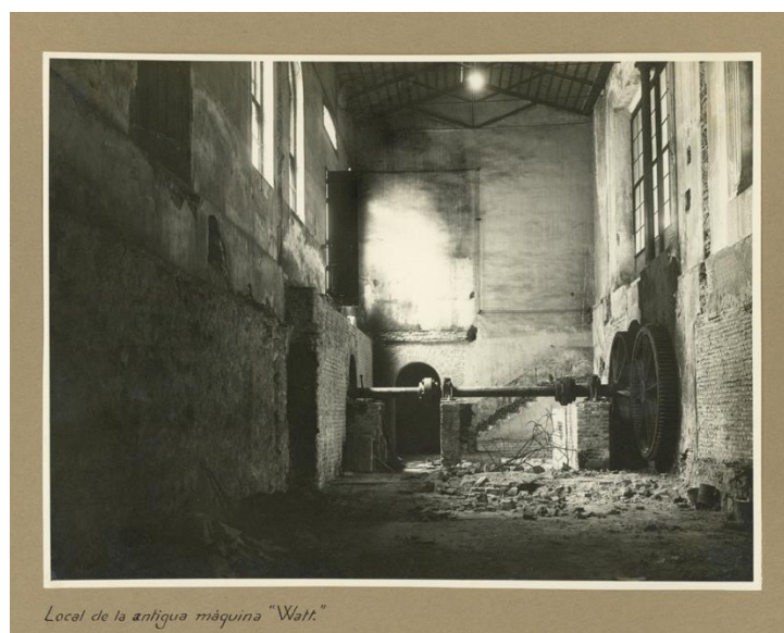
Figura 36: Local de la antigua máquina "Watt" [14]
