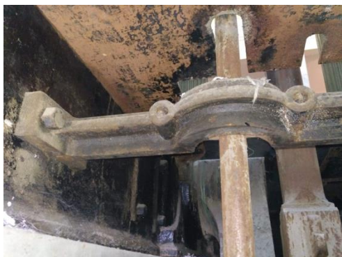
Figura 87: Barra vertical. Vista inferior (1)
