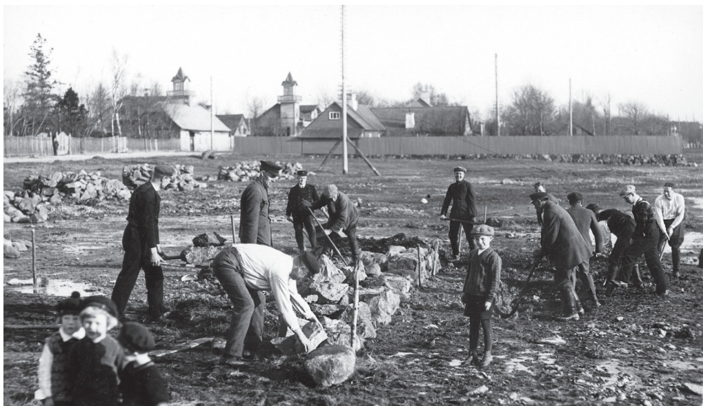
JOONIS 24. Pargi ja kaldakindlustuse rajamine Õhtu-Kaldal. Seda tänavat pikendati 1928. aastal raudteejaamani, et saabuvad külalised ei peaks tolmu sees linna kõndima.
