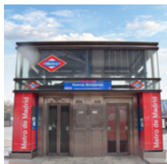
Entrada por ascensor
