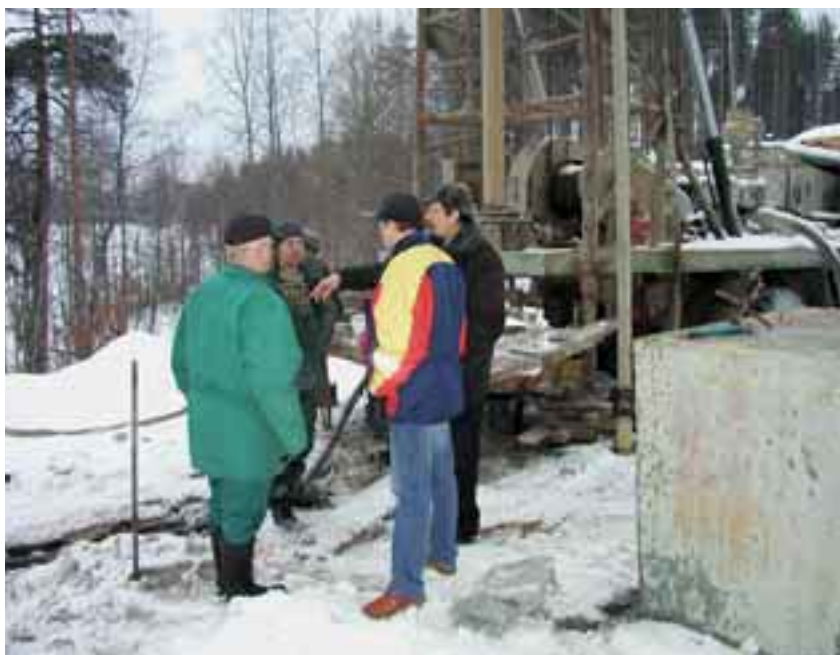
Siiviläputkikaivoja asennetaan Präässä pietarilaisella kalustolla. Pohjois-Karjalan ympäristökeskuksen, urakoitsijan ja Prääsän piirin edustajat neuvonpidossa keväällä 2005. (Kuva: Matti Partanen)
