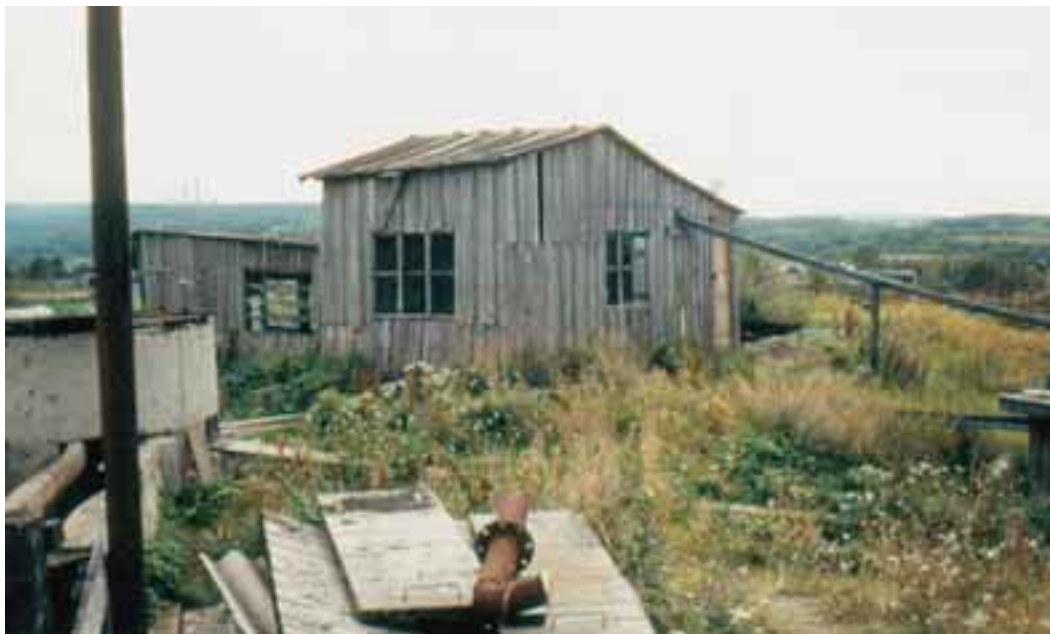
Kuva 1. Tyypillinen pienehkön jäteveden puhdistamon esikäsittelyrakennus. Paikka on 6500 asukkaan Molochnoe Kolajoen alajuoksun varrella. Välpät ovat käsin puhdistettavat ja hiekka poistetaan erotuskanavasta lapioimalla. Puhdistamossa on emscher-kaivot ja niiden jälkeen perinteiset sepelisuodattimet.
