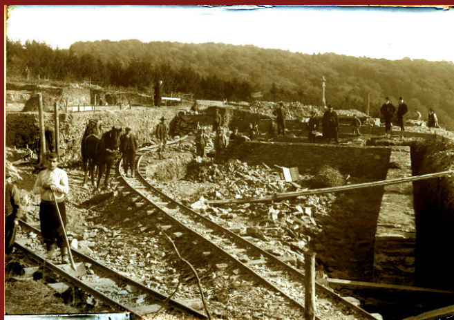
LES TRAVAUX DE LA CONSTRUCTION ...
