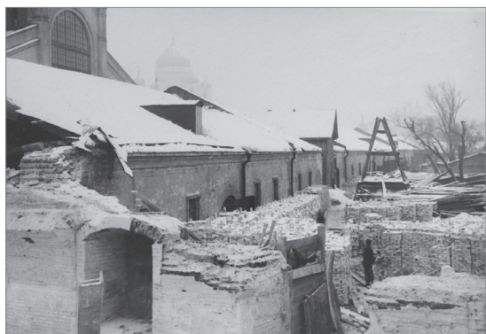
En la imagen superior, entrada al Almacén del Vino y la Sal. En el centro, la central eléctrica. En la imagen inferior, casa cercana a la central eléctrica.
