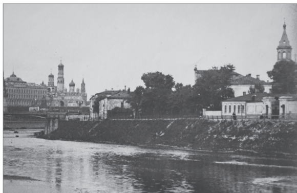
En la imagen superior, iglesia de San Nicolás Taumaturgo. En la inferior, vista del malecón de Bersenev desde la presa.
