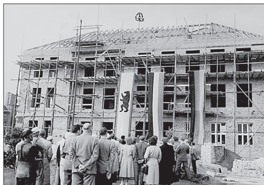
Abb. 18: Thielallee 63/67. Richtfest des wiederaufgebauten Südflügels (1952).
