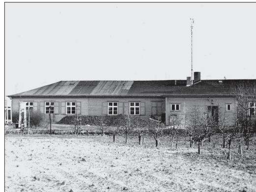
Abb. 26: Otto-von-Simson-Straße 20 (ehem. Kiebitzweg, um 1950).
