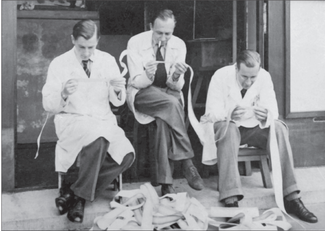
Abb. 7: Arnold Flammersfeld, Wolfgang Gentner und Peter H. Jensen (v. l. n. r.) um 1940 bei der Auswertung von Messungen zur Energie der Spaltungsneutronen. Die Impulse wurden über Schleifenzillographen auf Fotopapierstreifen aufgezeichnet; so konnten die koinzidierenden Impulse bestimmt und vermessen werden.
