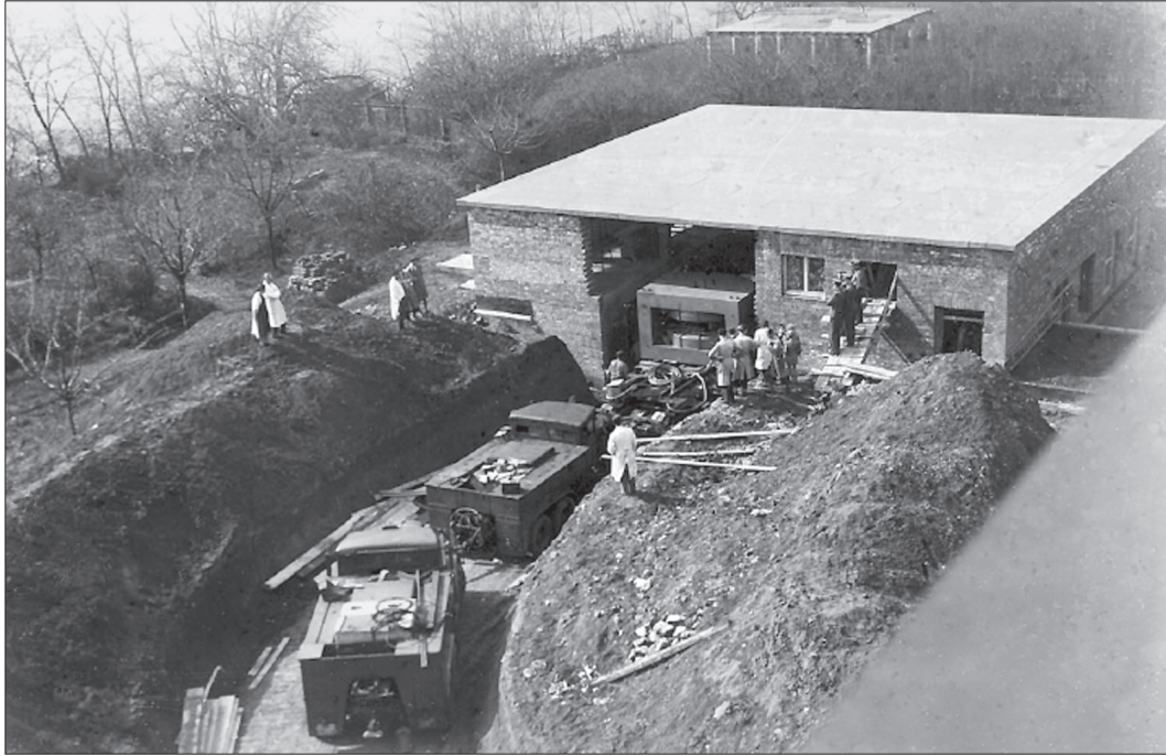
Abb. 5: Der Magnet für das Zyklotron wird in den Zyklotron-Bunker neben dem Institutsgebäude hineingebaggert (März 1943).
