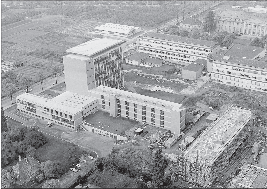
Abb. 31: Fabbeckstraße, Arnimallee, Takustraße. In der Mitte das Institut für Anorganische Chemie, dahinter die lange Front des Physiologischen und des Physiologisch-chemischen Instituts (Arnimallee 22, dahinter der Museumskomplex), vorn rechts, noch eingerüstet, das Institut für Mineralogie.
