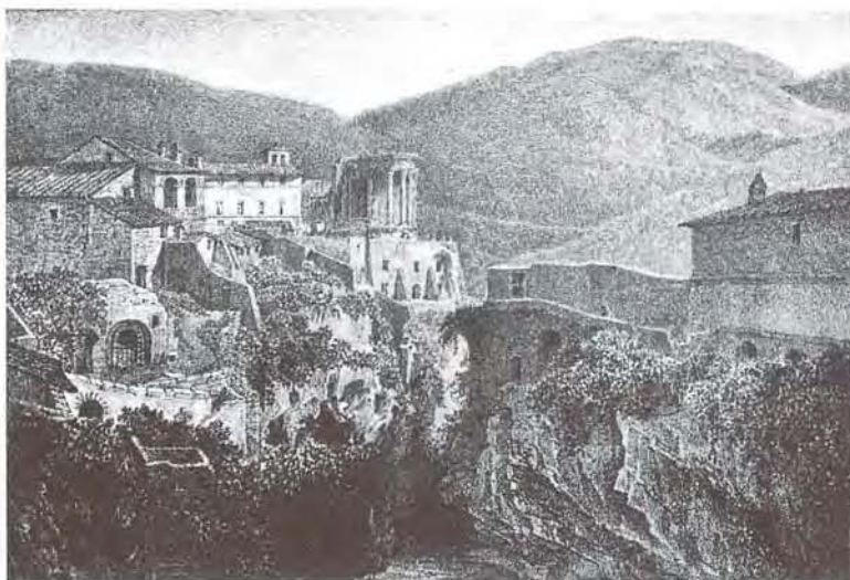
Il ponte di S. Rocco distrutto.
