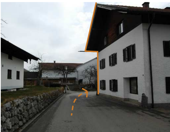
Verengung der Straße durch Gebäudestellung
