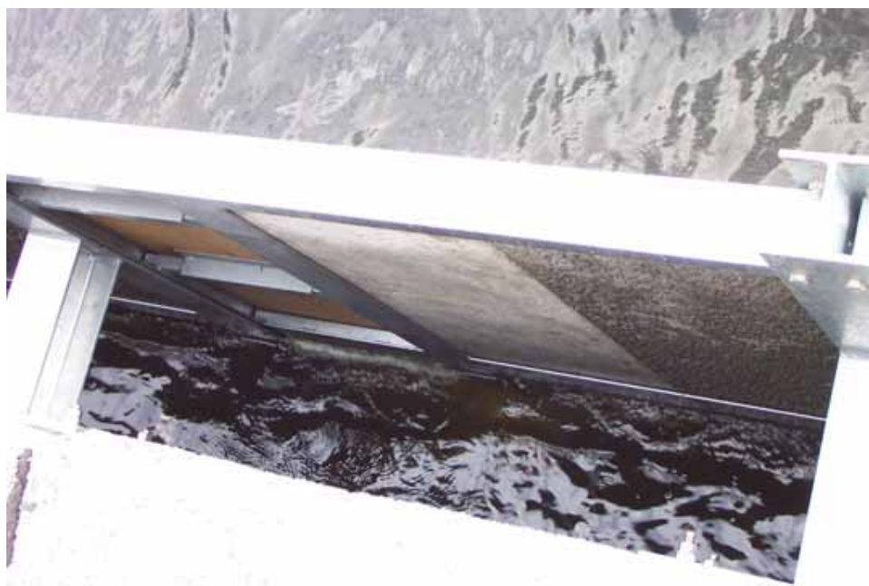
図 1.3.6 設置後壁面裏側
