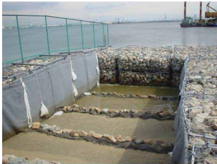
図 4.5.1 石積堤を用いた閉鎖性干潟の実証実験施設
