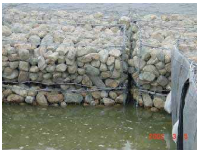
図 1.5.2 石積堤を用いた閉鎖性干潟の実証実験施設
