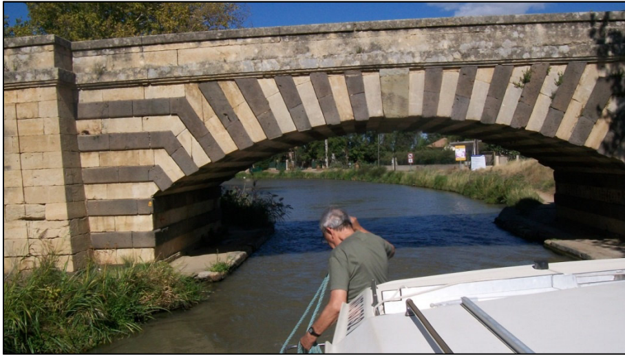
Segmentbogen - Brücke über dem Canal du Midi, Südfrankreich
