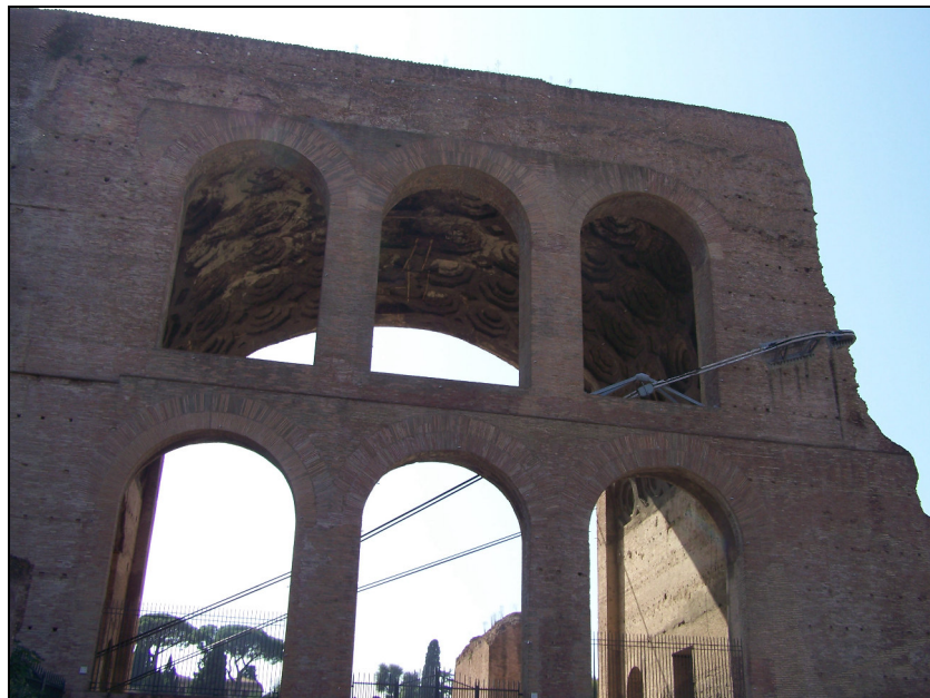
römische Bögen und Tonnengewölbe (Maxentiusbasilika, Rom)
