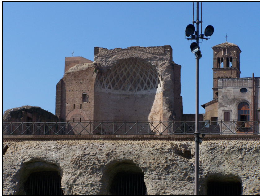
Halbe Kuppel (Apsis), Rom. Die Kuppel und die Gewölbe im Vordergrund bestehen aus Beton.
