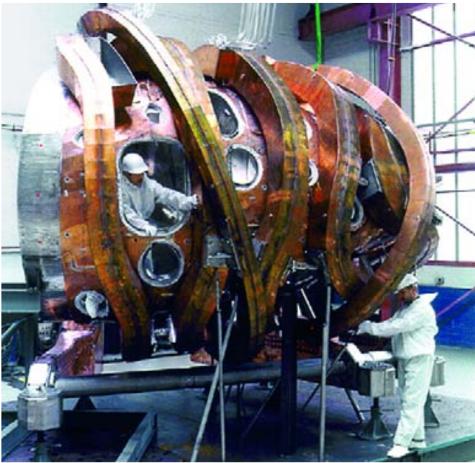
Abb. 19: Der Testkryostat für Wendelstein 7-X während der Montage. (Foto: Balcke-Dürr AG)
