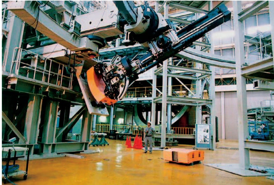
Abb. 13: Blanket-Testanlage in Naka, Japan: Sie simuliert die Innenregion des halben Plasmagefäßes. Mit einem Greifarm ausgerüstete fahrbare Roboter handhaben die Blanket-Module. (Foto: ITER)
