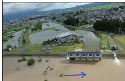
21 太田川ポンプ排水 (五泉市三本木)
