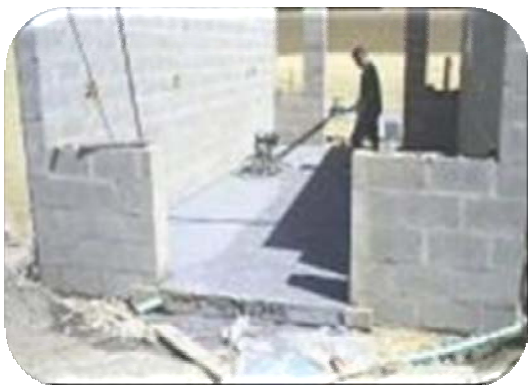
Figura No. 2- 89. Interventoría de construcción para la obra "Construcción Laboratorio de Arenas y Ampliación Capacidad Taller de Modelos en la Planta de Fundición de la Fábrica Santa Bárbara – Sogamoso
