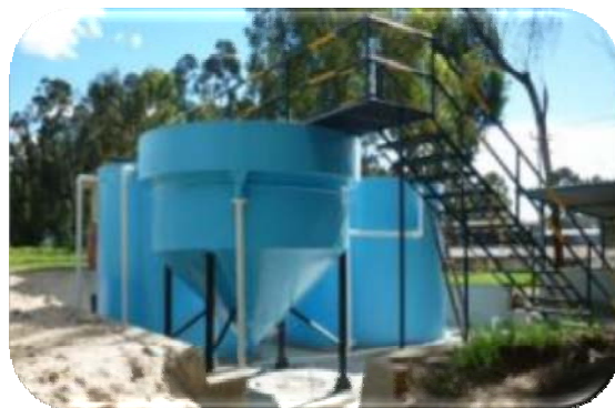
Figura No. 2- 129. Sistema Biológico de Lodos Activados
