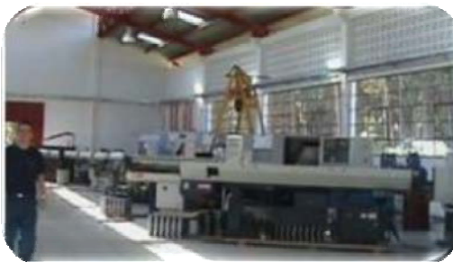
Figura No. 2- 102. Pruebas conectividad
