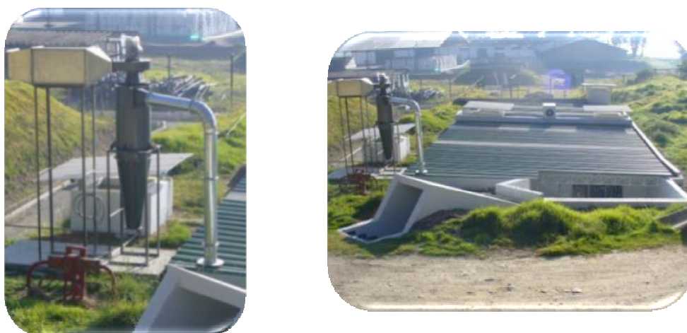
Figura No. 2- 18. Nuevas instalaciones físicas Laboratorio de Propelentes Sólidos
