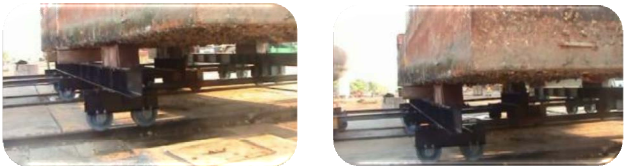
Figura No. 2- 120. Montaje conjunto rueda para operación.
