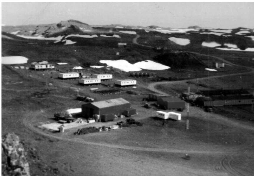
Villa Las Estrellas en construcción. A la derecha se distingue el camino que sube hacia el aeródromo Teniente Marsh.
