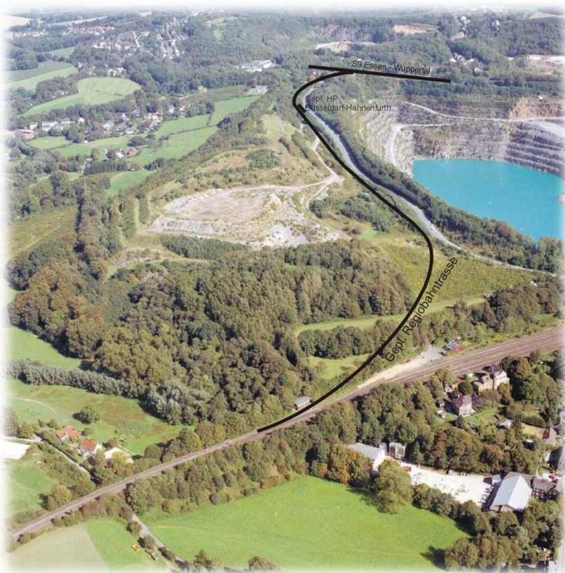
Luftbildaufnahme Dornap-Hahnenfurth Einschleifung Regiobahn auf Strecke S9
