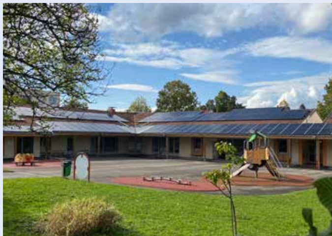
• Fin des travaux de rénovation énergétique à l'école Mermoz
