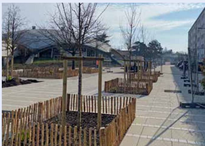
• Début des travaux sur la Place de Munderkingen
